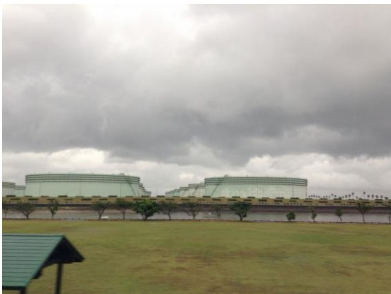
写真1 石油貯蔵タンク(飯山和也会員撮影)
